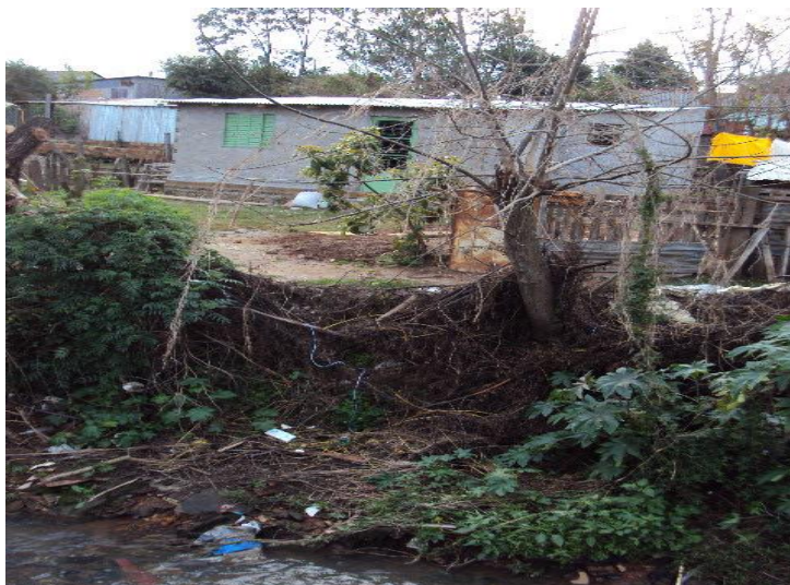
Fig.6 – Moradia irregular no bairro Beira Rio, em São Gabriel-RS. Fonte: Autoras
